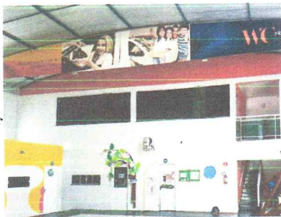
Escada de acesso à diretoria e Secretaria
